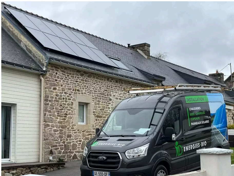
Installation de panneaux solaires dans le Pays de Lorient © ID Energies Bio
