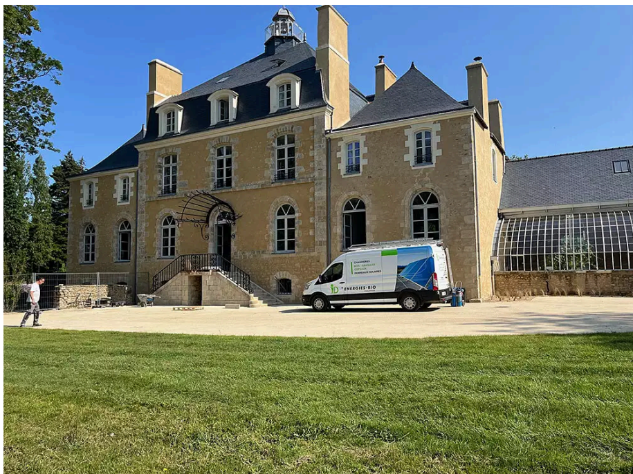
Installation de 660 kw granulés et copeaux pour un réseau de chaleur au Domaine du Mezo à Ploeren (56) © ID Energies Bio
