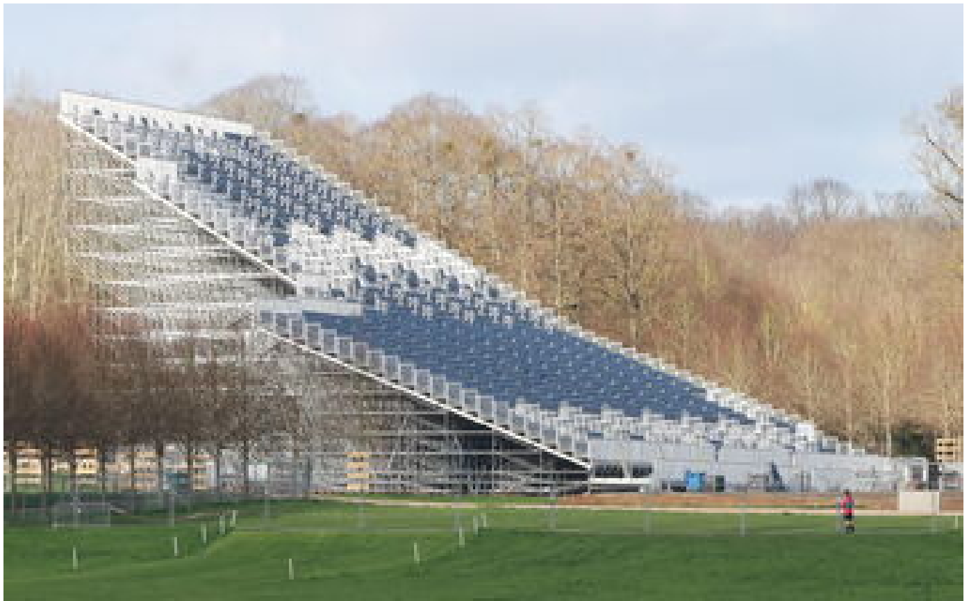
JO Paris 2024 : à Versailles, les travaux interrompus par l'inspection du travail
