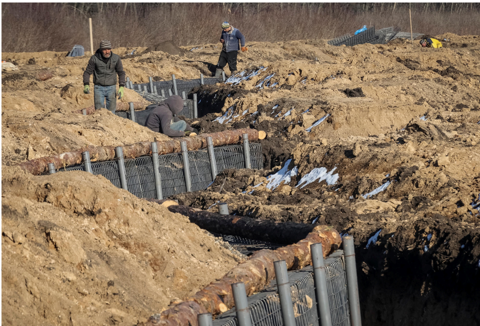
Des travailleurs renforcent avec des rondins une tranchée nouvellement construite, faite dans le cadre d'une nouvelle ligne de fortification, dans la région de Kharkiv, le 12 mars 2024. [REUTERS - Vyacheslav Madiyevskyy]
