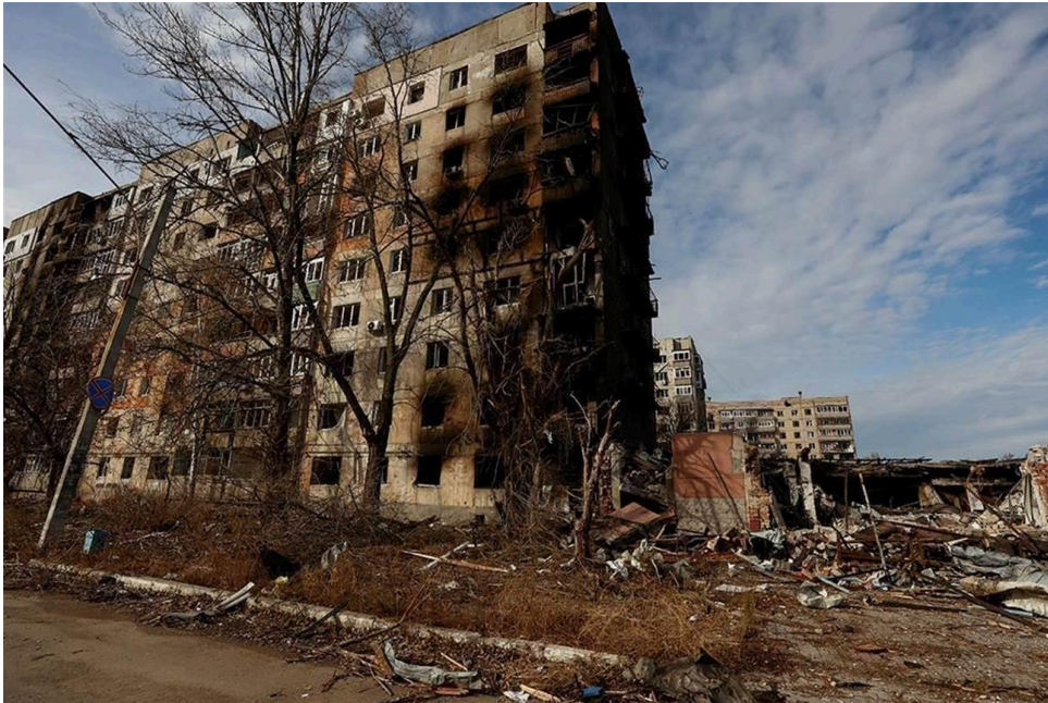
Des bâtiments endommagés dans la ville d'Avdiivka en novembre 2023. [Reuters]
