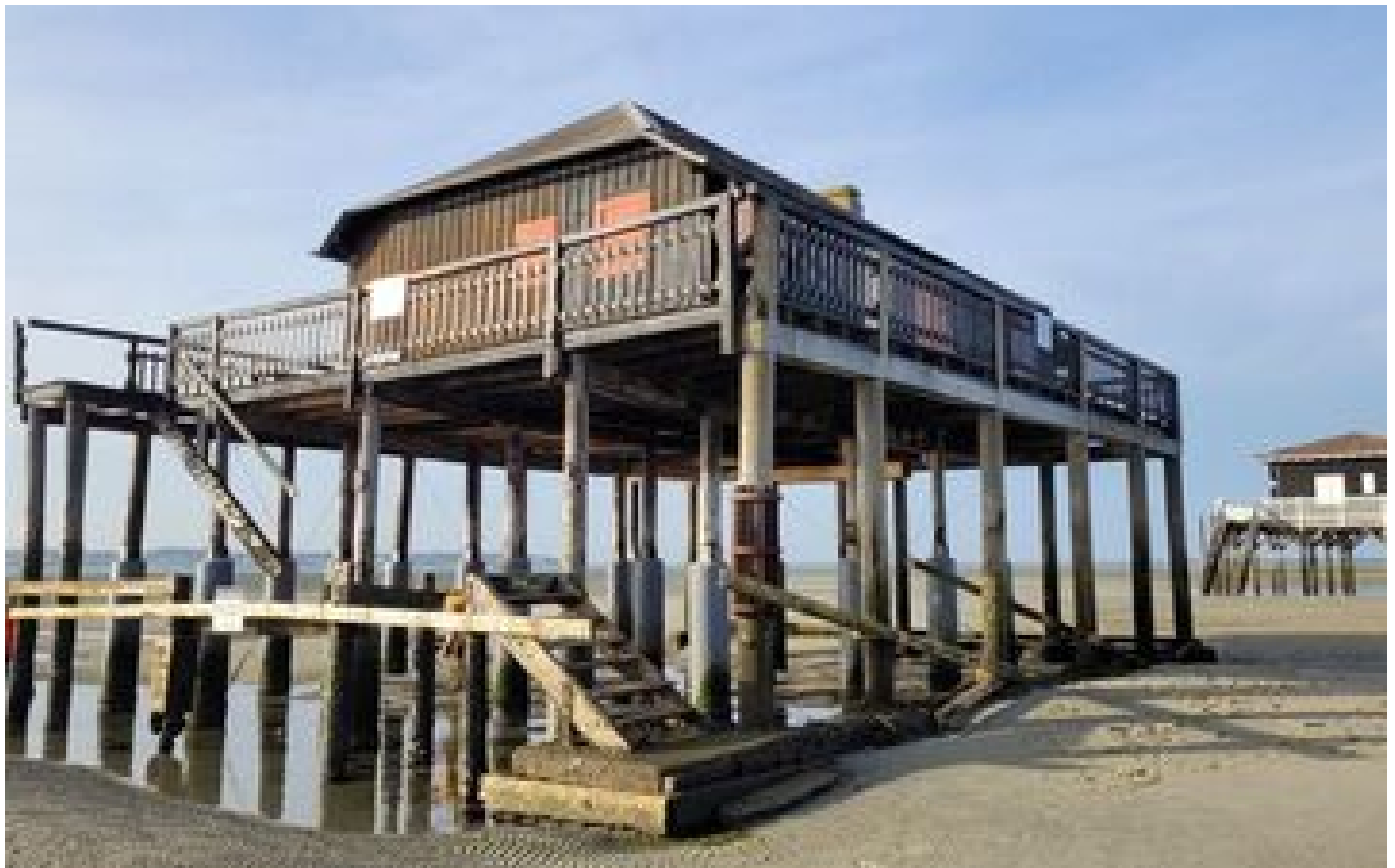
Emblème du bassin d'Arcachon, la cabane tchanquée aux volets rouges va retrouver sa splendeur P
