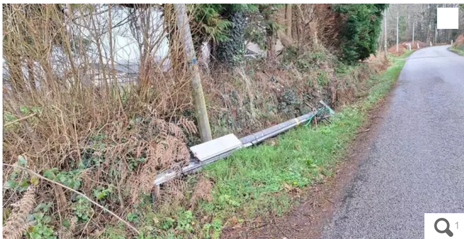
C'est la chute de ce poteau au village La Fontaine-du-Vin lors du passage de la tempête « Ciaran » que le village Bugoz-Izel est sans internet depuis deux mois. © Ouest-France
