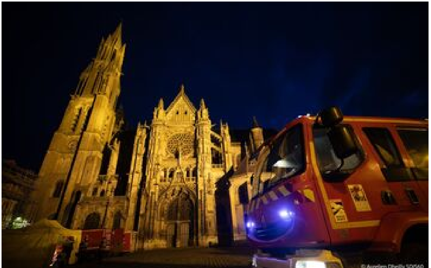
Senlis : un incendie se déclare dans un local technique de la cathédrale
