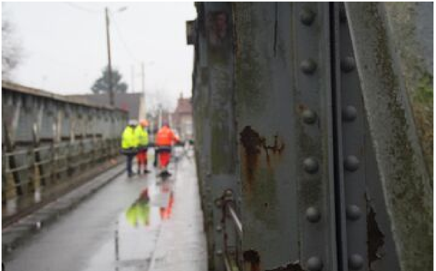
Entre Montmacq et Thourotte, les deux ponts fermés pendant un mois
