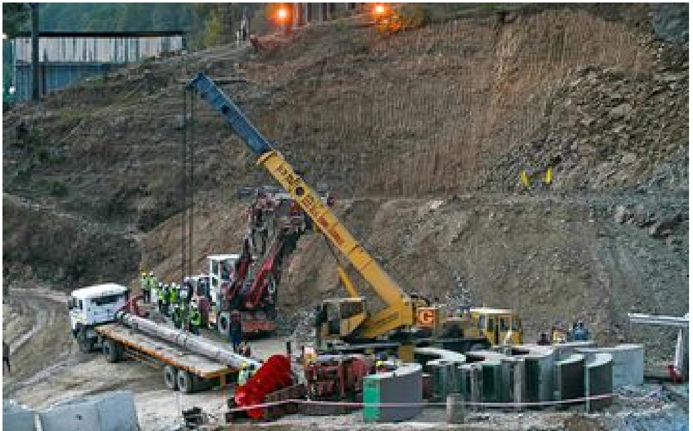
Inde : les sauveteurs ont commencé à forer verticalement le tunnel où 41 ouvriers sont piégés depuis deux semaines
