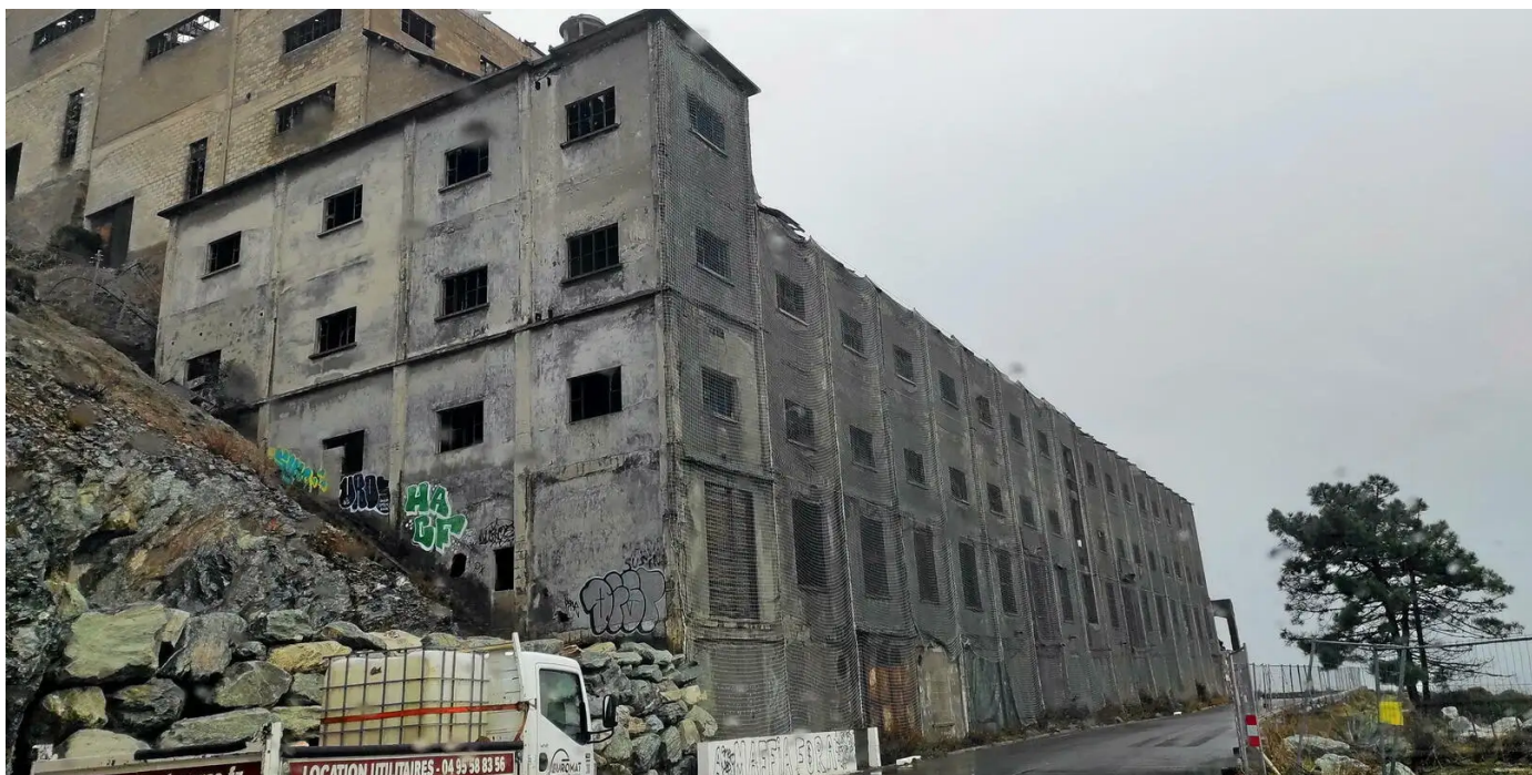
La carcasse de l'usine présente des risques. © Julian Mattei
