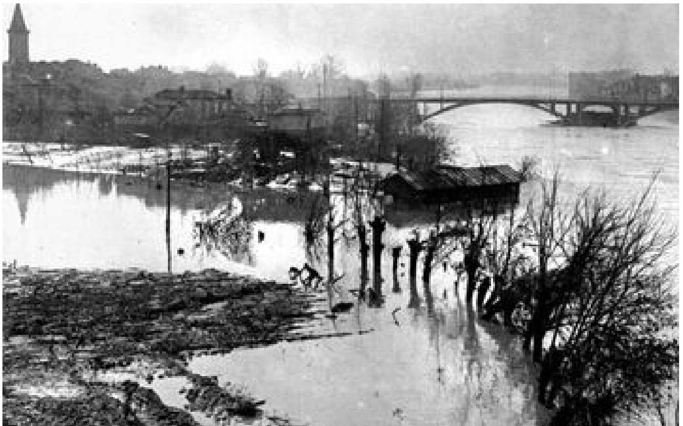
En 1930, des inondations catastrophiques ravagent le Sud-Ouest P
