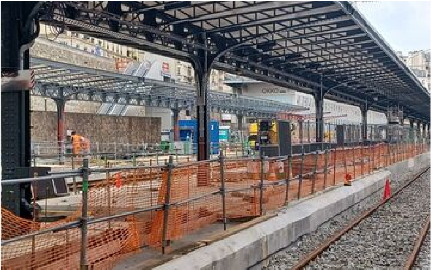
CDG Express : voies, aiguillages, quais, bâtiment voyageurs... discrètement, la future ligne trace sa route P
