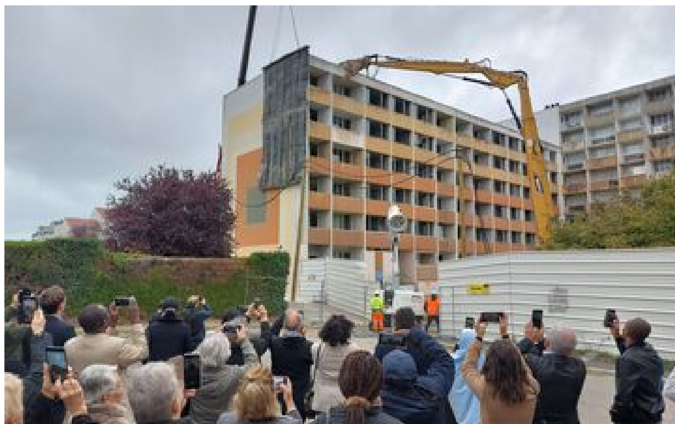
Travaux dans les cités sensibles : à Montereau, le gérant d'une société de démolition racketté P
