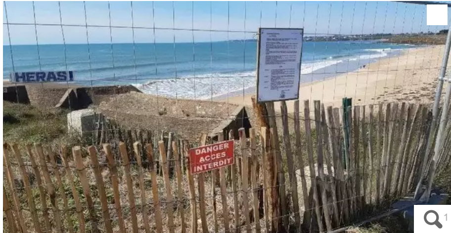
Lorient Agglomération lance lundi 19 juin 2023 des travaux de stabilisation de l'ouvrage du Loc'h à Guidel. © Ouest-France
