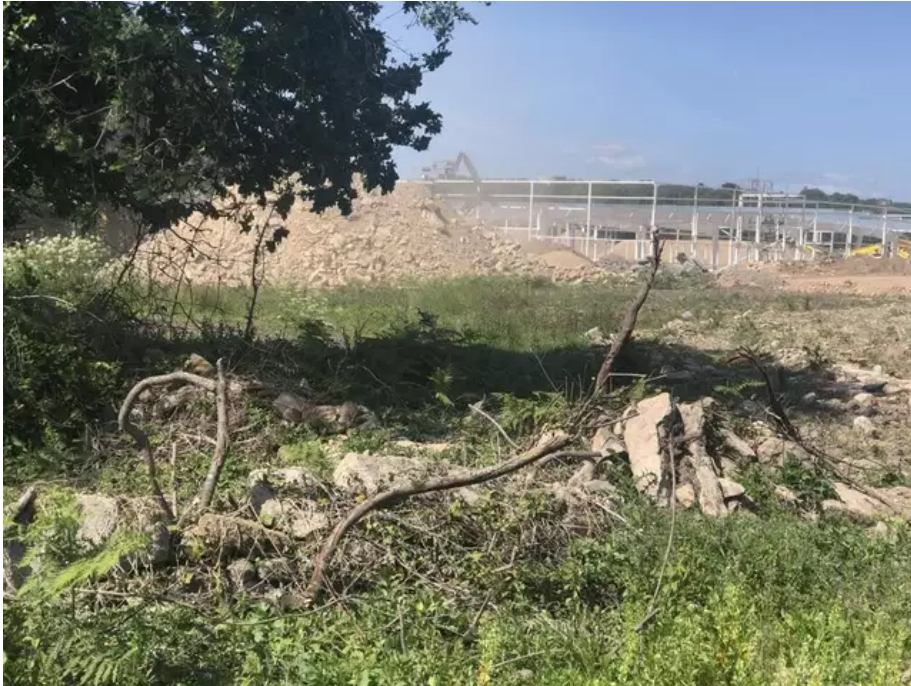
Le site de la zone de Montauban, devant le chantier de construction de l'enseigne de bricolage. © OUEST FRANCE
