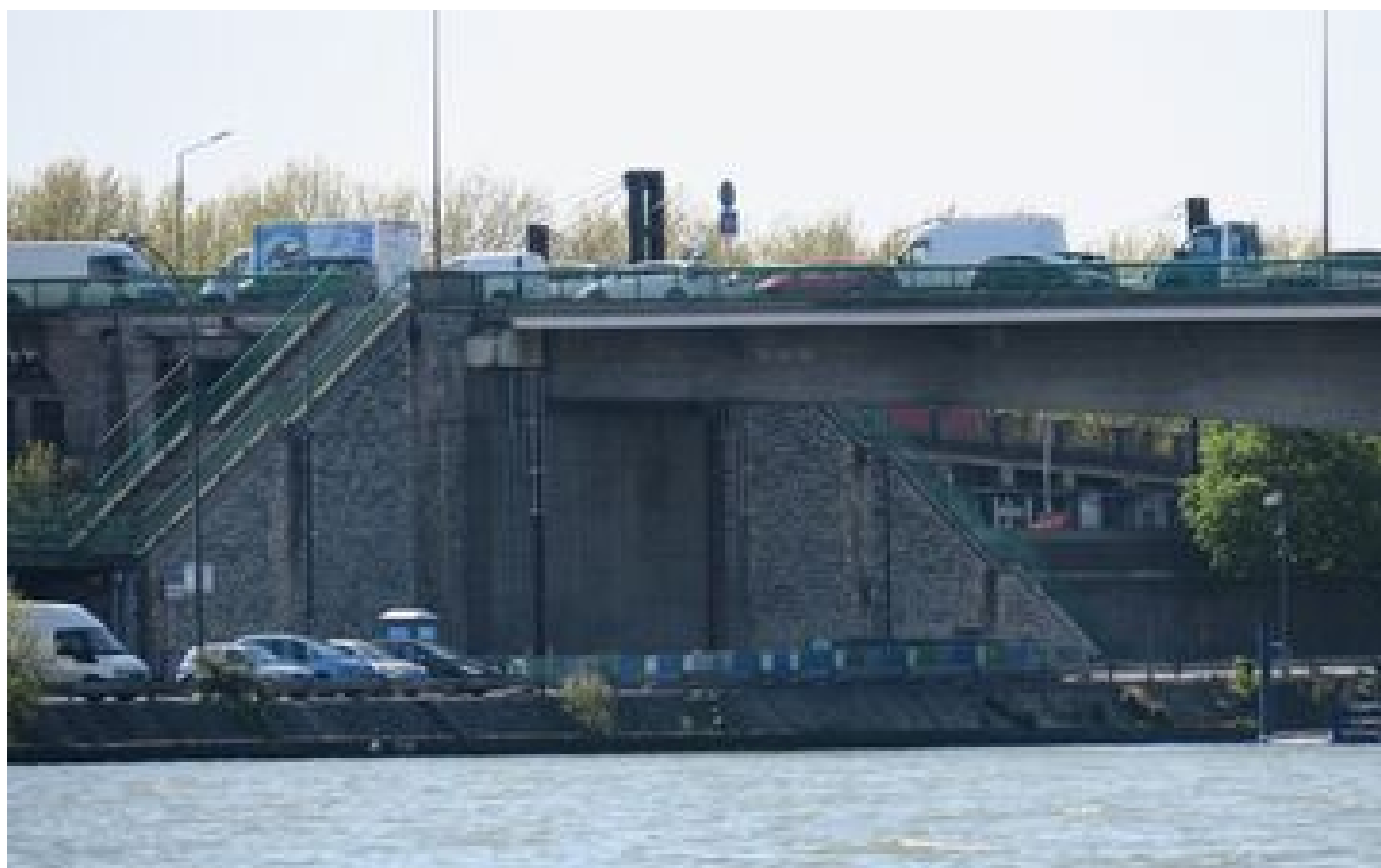
Travaux sur le pont de Villeneuve-Saint-Georges : gare aux embouteillages P
