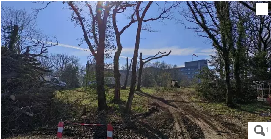
L'aire d'atterrissage de l'hélicoptère de l'hôpital nord Laennec à Saint-Herblain (Loire-Atlantique) est en cours de déblayage. © Ouest-France
