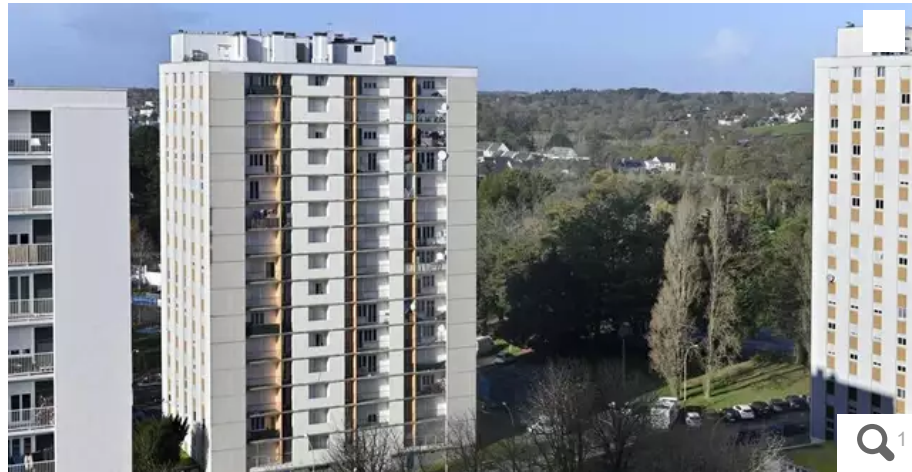
Le chantier de démolition de la tour numéro 2 (au milieu) de Bois-du-Château, à Lorient (Morbihan), doit débuter en avril 2023. © Thierry Creux / Ouest-France
