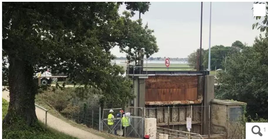
Le projet prévoit le remplacement des vannes des étangs du Ter comme celle de Kermélo pour garantir la continuité piscicole et sédimentaire, ainsi que la bonne qualité de la masse d'eau. © Ouest-France
