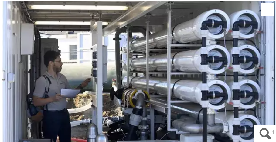
Lorient Agglomération compétente en matière de production et de distribution d'eau potable sur l'île de Groix a procédé à l'installation d'une unité de dessalement d'eau de mer temporaire, sur le site de Port-Melin. Sur la photo : Benjamin Gury (de la SLCE, spécialisée dans ce type d'équipement), dans l'un des deux modules de dessalement. © Thierry Creux / Ouest-France
