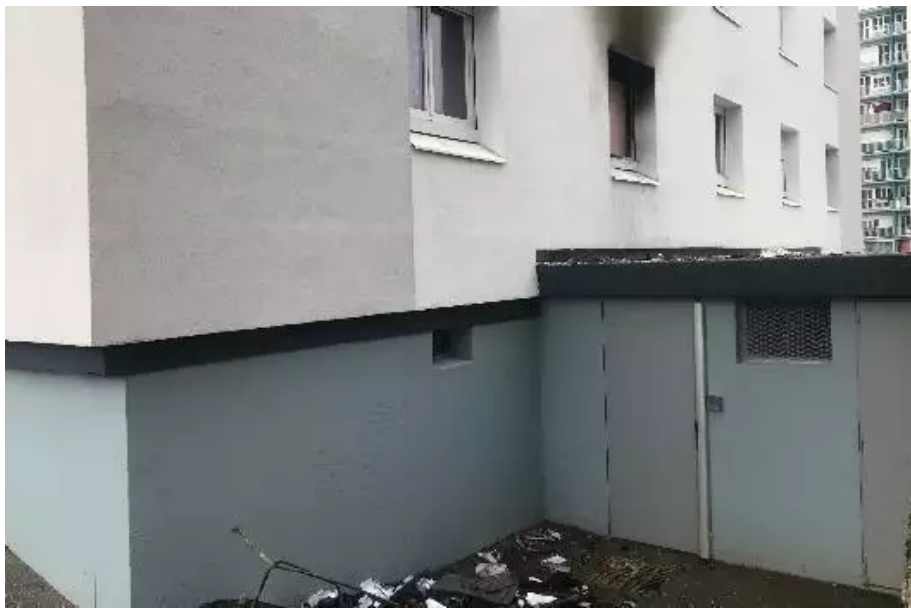
Des débris calcinés au sol et l'encadrement de la fenêtre noirci par les fumées témoignent de l'incendie survenu vers 14 h ce samedi. © OUEST-FRANCE
