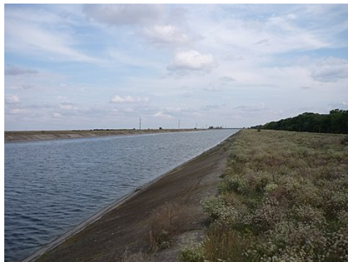
Vue du canal de Crimée du Nord à Djankoï.
