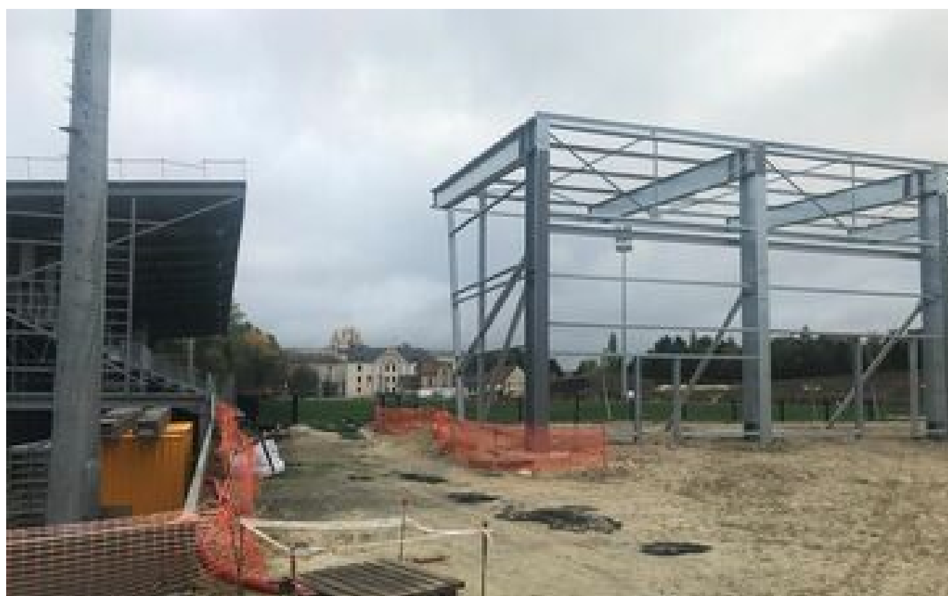
Stade Walter-Luzi de Chambly : l'arrêt des travaux pour six mois provoque la colère des dirigeants du club
