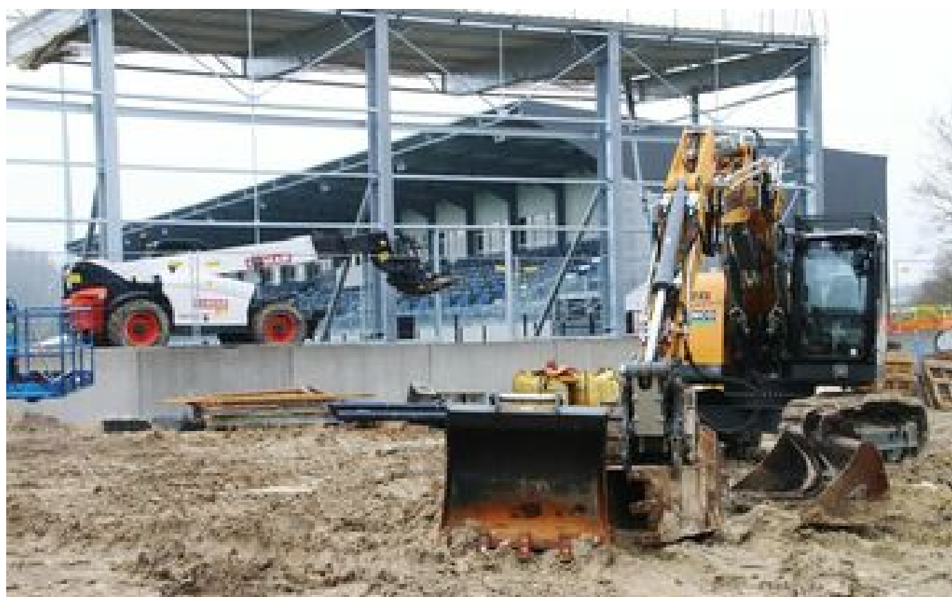
Achevé à 85%, le chantier du stade de Chambly reste à l'arrêt
