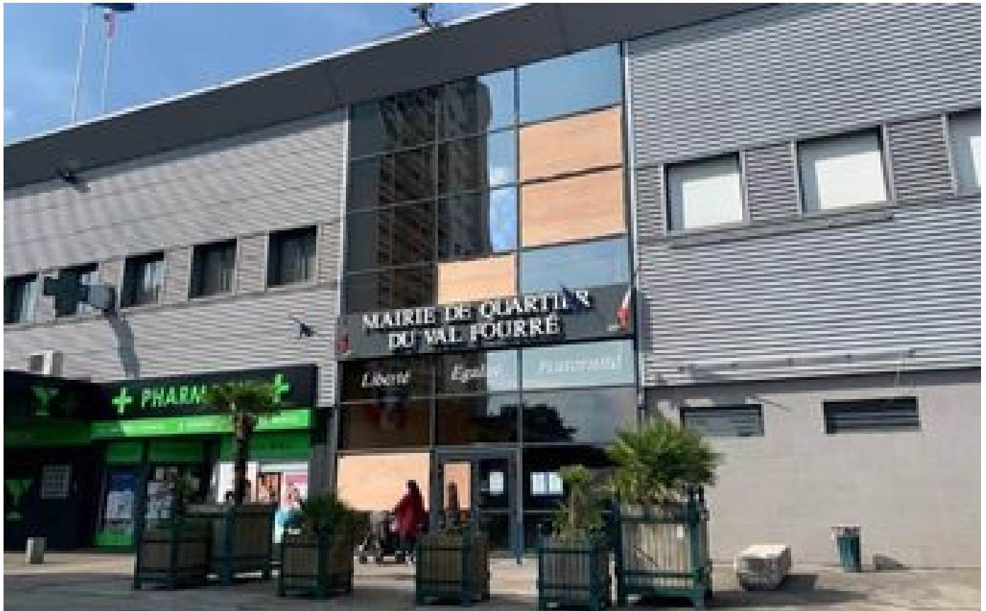
Tirs de mortier, voitures incendiées, mairie de quartier dégradée... Nuit de violences urbaines dans les Yvelines
