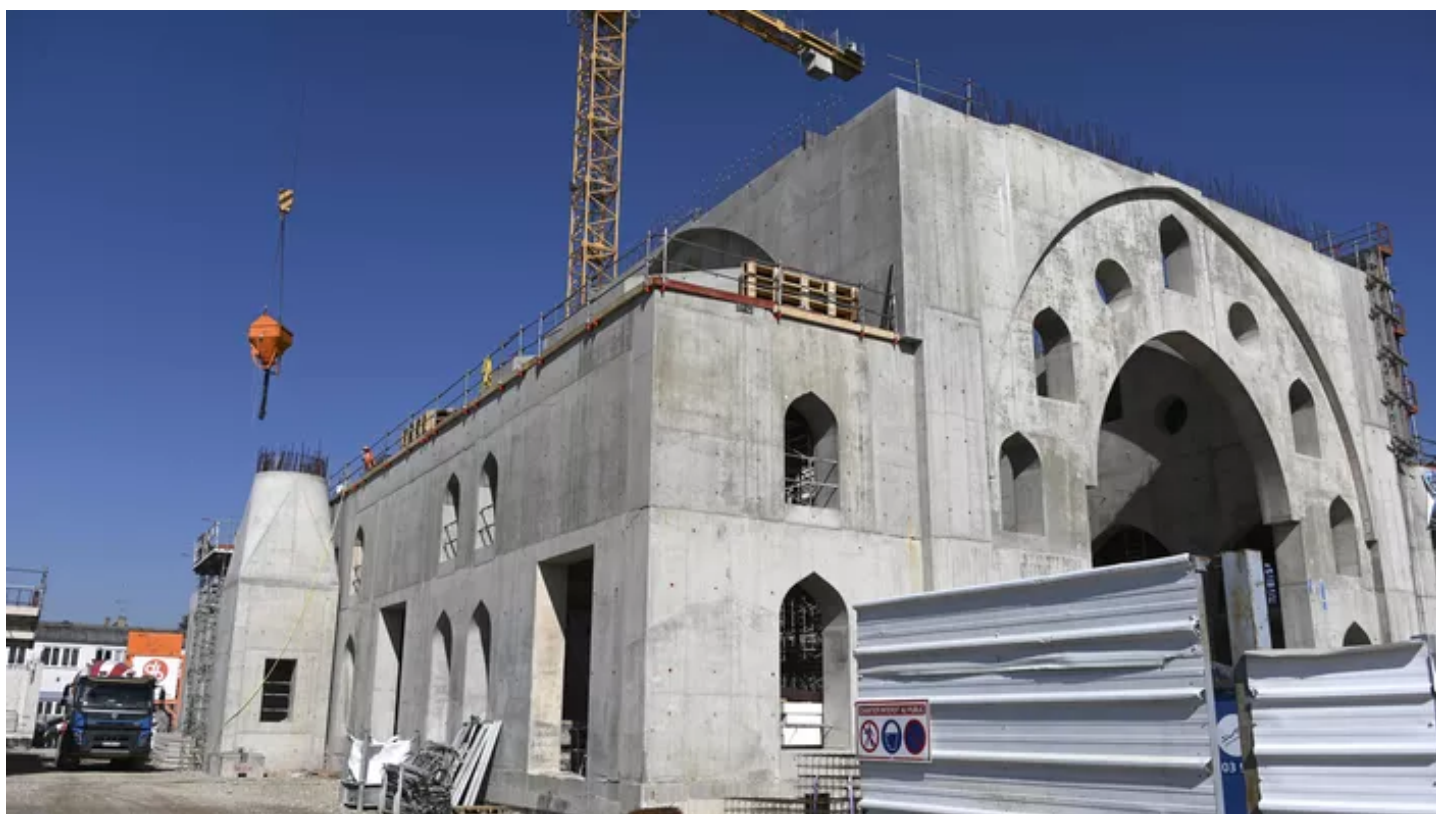
La grande mosquée de Strasbourg, en chantier. FREDERICK FLORIN / AFP
